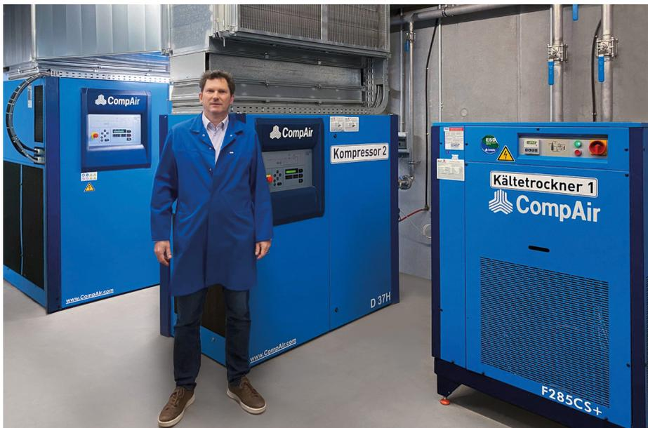
**02** Der neue drehzahlgeregelte Schraubenkompressor (im Bild links) speist 100% ölfreie Druckluft im Volumenstrombereich von 2,2 bis 11,4 m³/min in den zweiten Strang ein
