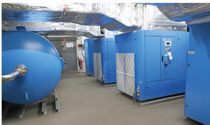
**02** Boge lieferte zwei Schraubenkompressoren sowie Mikrofilter, Kältetrockner und einen nachgeschaltete Converter
