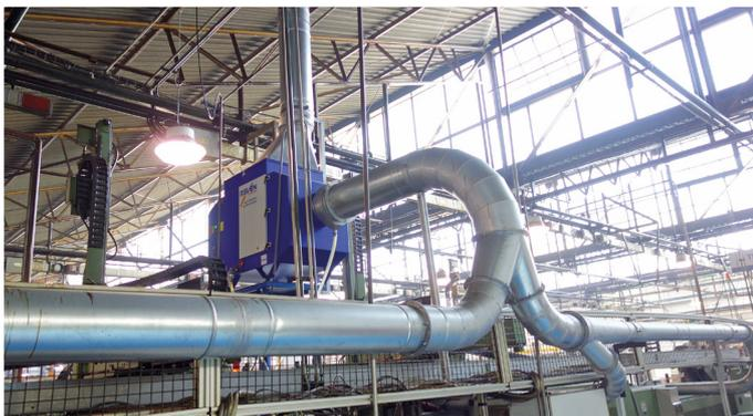
**02** Lange Sammelkanäle kennzeichnen die zentrale Lösung
